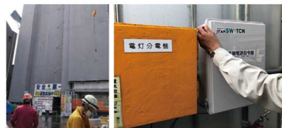
既にある仮設分電盤に JITAN スイッチを取付けて利用
